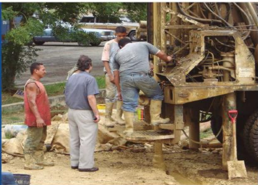
Perforación geotécnica en Barquisimeto (2006).
