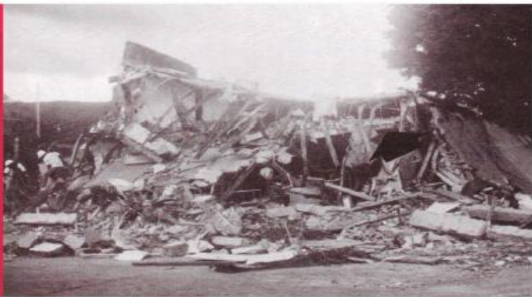
Colapso parcial del edificio del Banco Orinoco, Cariaco.
