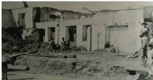
Demolición de la casa de la esquina de Los Traposos, hacia el S. O. Caracas.
