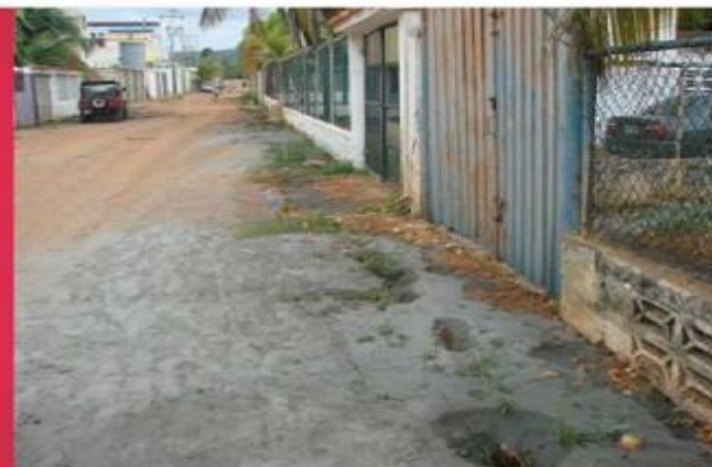
Alineación de volcanes de arena (Fenómeno de licuación de suelos) en calle residencial del sector Playa Sur de Chichiriviche. Sismo del 12 de septiembre del 2009. Fuente: Javier Oropeza (2009).
