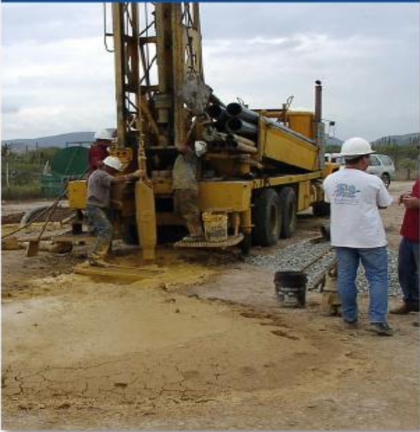
Proyecto GEODINOS, 2003: Perforación de pozos para una voladura, estado Falcón.
