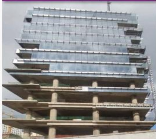
Edificación en construcción. Av. Francisco de Miranda, Chacao, Distrito Capital. Fuente: Mario Rendón (2022).
