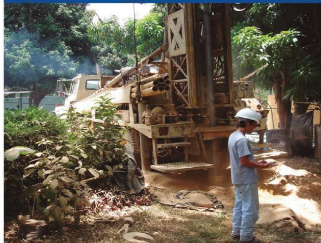
Perforación para instalación de observatorio acelerográfico en Caracas (2005).
