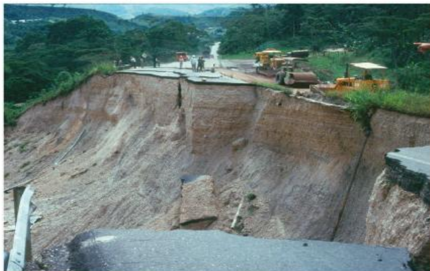
Colapso cosísmico del terrapién de San Joséito durante el sismo del 18/10/1981, con destrucción del barrio marginal ubicado al pie del talud por un flujo de barro. Fuente: Roberto Centeno (1981).
