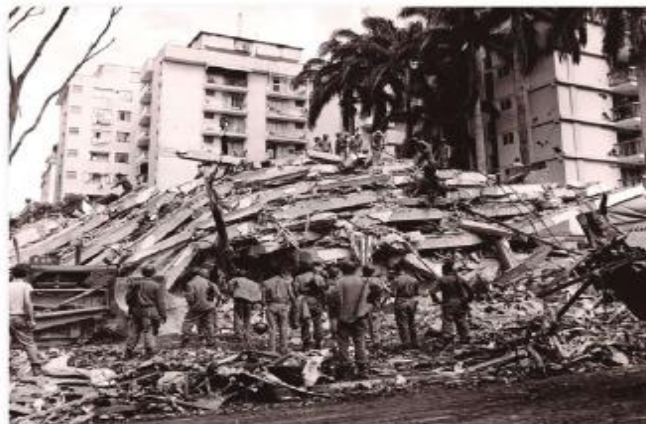
Escombros del edificio Mijagual. Fuente: Comisión Investigadora del Sismo (1967).
