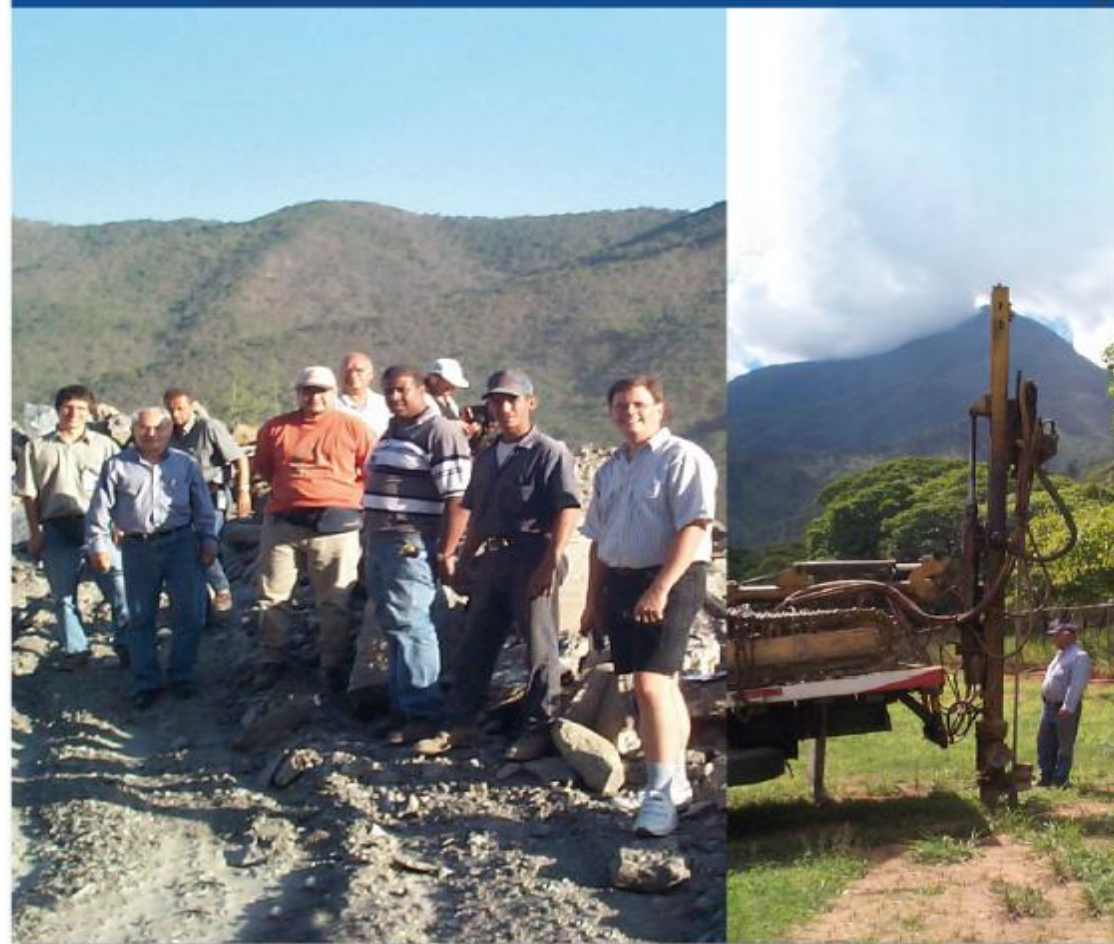
Perforación para mediciones sísmicas (izquierda) y búsqueda de puntos de medición (derecha) en Caracas (2001).
