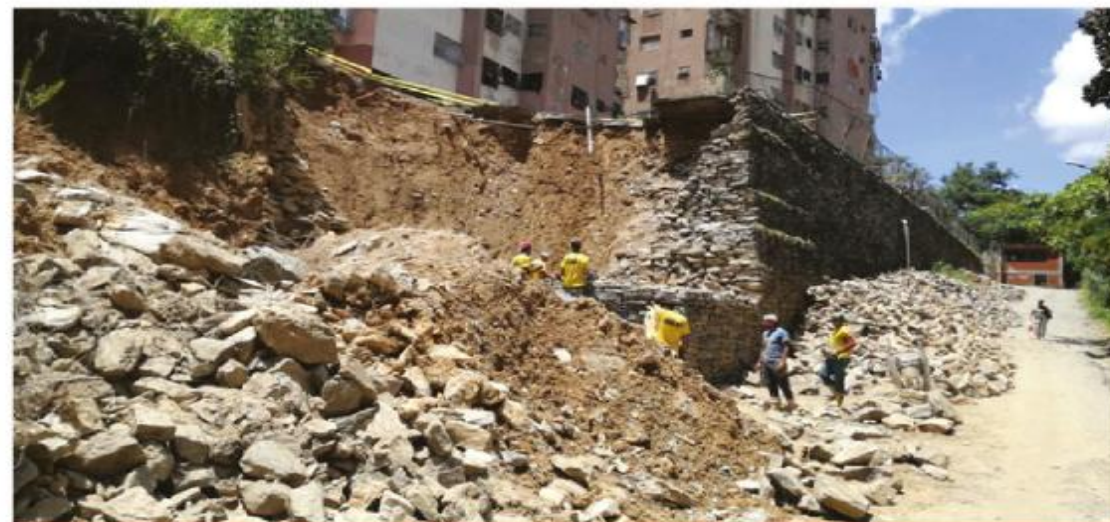
Deslizamientos en zonas populares de Caracas, activados por lluvias torrenciales y por efectos antrópicos (cargas normales por edificaciones e inyección de aguas residuales). La foto superior pertenece a un conjunto residencial de Petare, en la cual la pared perimetral que rodeaba la urbanización colapsó por la saturación del suelo en temporada de lluvias, la foto inferior pertenece a un deslizamiento en ladera del barrio Fenix, Petare, originado por la conjugación de efectos antrópicos y saturación de suelos. En los dos casos se observa el gran espesor de suelo residual en la cual están asentadas las viviendas o urbanismos. Fuente: Informe técnico de Funvisis (2016).
