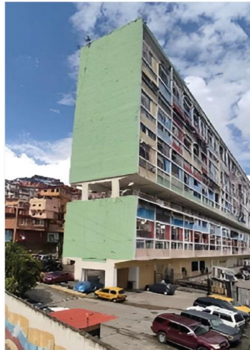
Edificio Residencia Cerro Grande, Av. Intercomunal, parroquia El Valle, Municipio Libertador, Distrito Capital. Construido en la década de los años 50. Fuente: Mario Rendón (2022).
