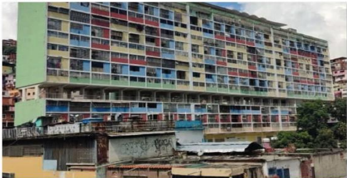
Edificio Residencia Cerro Grande, Av. Intercomunal, parroquia El Valle, Municipio Libertador, Distrito Capital. Construido en la década de los años 50. Fuente: Mario Rendón (2022).
