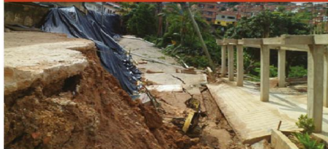
Deslizamientos en zonas populares de Caracas, activados por lluvias torrenciales y por efectos antrópicos (cargas normales por edificaciones e inyección de aguas residuales). La foto superior pertenece a un conjunto residencial de Petare, en la cual la pared perimetral que rodeaba la urbanización colapsó por la saturación del suelo en temporada de lluvias, la foto inferior pertenece a un deslizamiento en ladera del barrio Fenix, Petare, originado por la conjugación de efectos antrópicos y saturación de suelos. En los dos casos se observa el gran espesor de suelo residual en la cual están asentadas las viviendas o urbanismos. Fuente: Informe técnico de Funvisis (2016).
